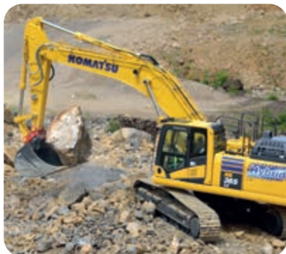
Eccezionali forze di scavo
