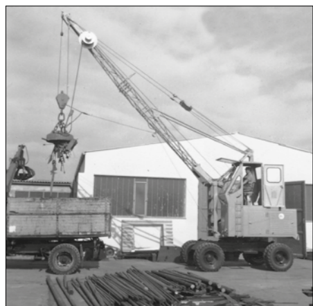
1962 : S833 à entraînement par câbles avec cabine conducteur surélevée
