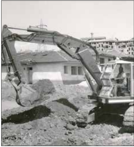
1976: S 517 mit Raupenfahrgerstell und Kunststoffkabine für Erdbebewegungen
