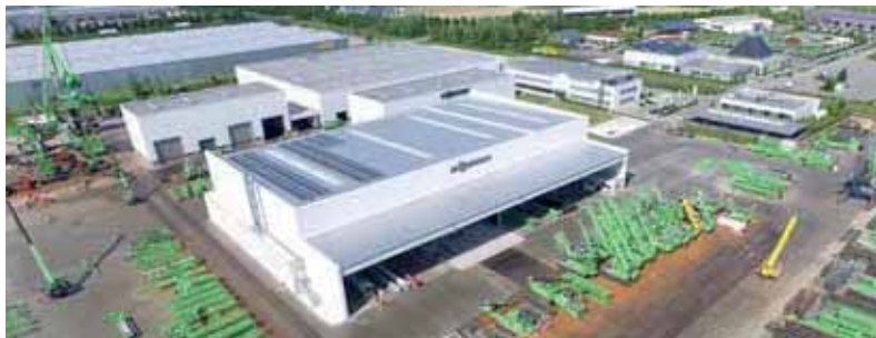
Factory 2, Straubing Port – production large machines Werk 2, Straubing Hafen – Produktion Großgeräte
