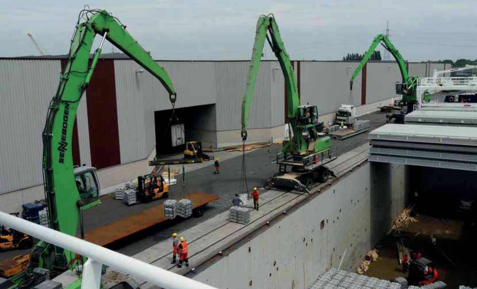
2 x 850 Mobile, 870 Mobile - handling concrete elements into ship; Belgium 2 x 850 Mobil, 870 Mobil - Einheben von Betonelementen; Belgien
