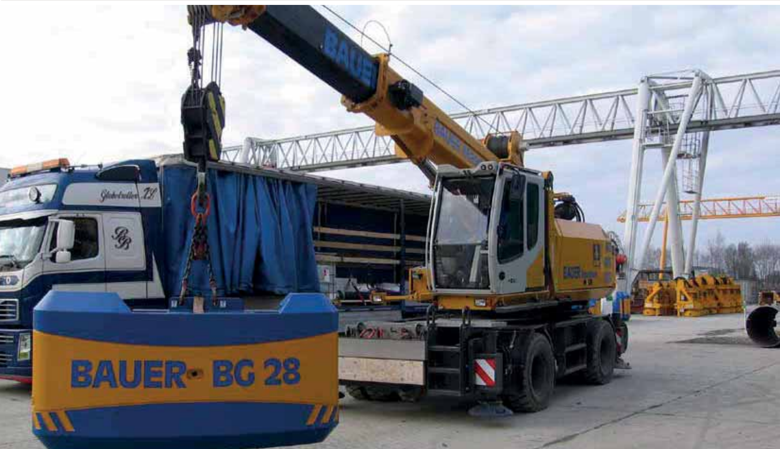
643 MI Telescopic Mobile Crane - hoist and moving of counter weight; Germany 643 MI Teleskopmobilkran - Heben und Verfahren eines Heckgewichts; Deutschland
