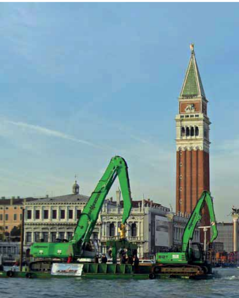
39 860/821 Crawler on pontoon - container handling of demolition waste; Venice 860/821 Raupe auf Ponton - Umschlag von Abbruchcontainern; Venedig
