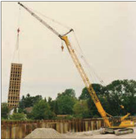
1976-1995: Raupenkran S 1225 mit Spitzenausleger beim Heben von Verschalungstafeln
