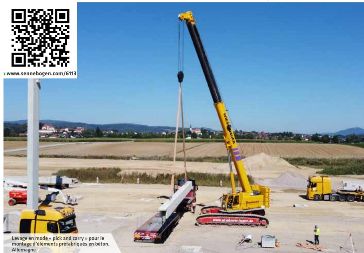
Levage en mode « pick and carry » pour le montage d'éléments préfabriqués en béton, Allemagne
