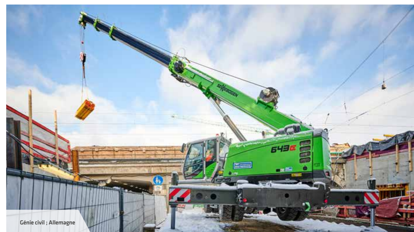
Construction de bâtiment ; Allemagne
