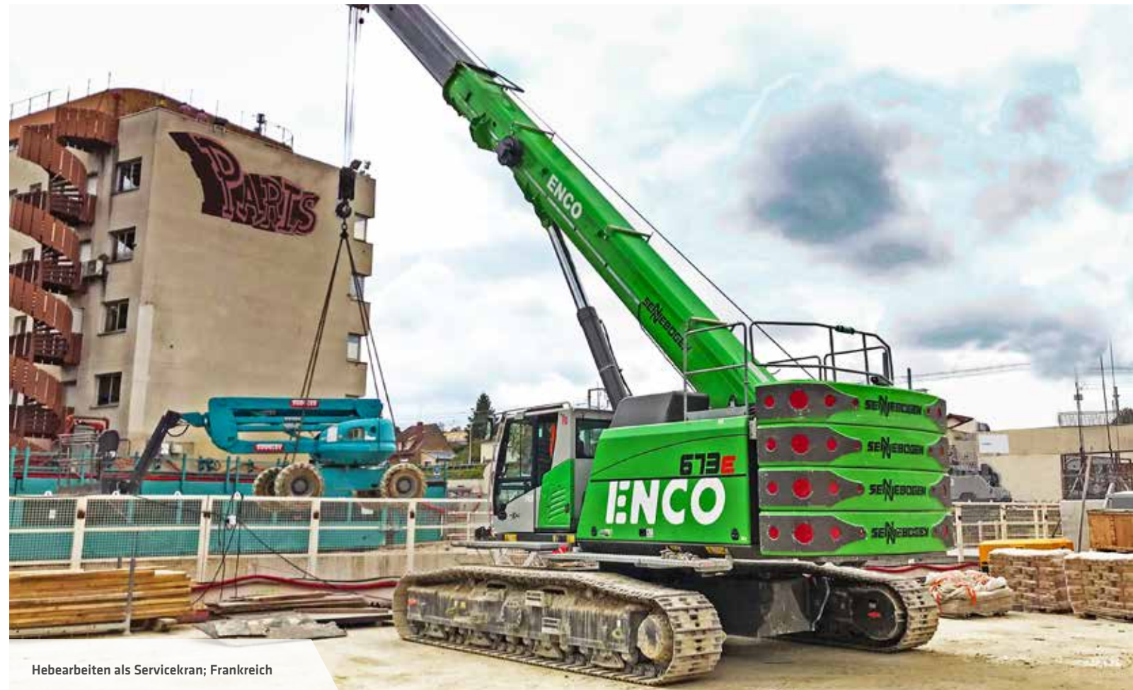
Spundwandmontage unter Stromleitung mit programmierbarer Arbeitsbereichsbegrenzung; Niederlande
