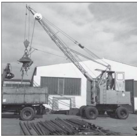
1962 : 5833 à entraînement par câbles avec cabine conducteur surélevée
