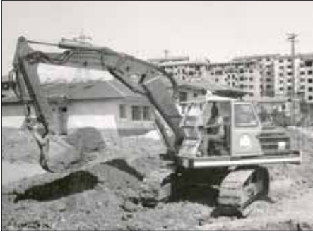
1976: S 517 mit Raupenfahrwerk und Kunststoffkabine im Erdbau
