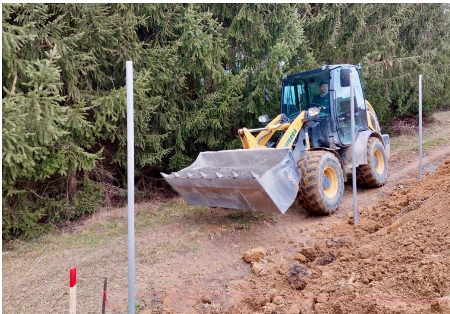
Bild 3: Die Komatsu Radlader von Kuhn sind vielseitige Maschinen, die bei Uniterra für diverse Aufgaben auf den Baustellen eingesetzt werden.
